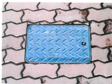
Pojezdový poklop – nosnost 12,5 t
